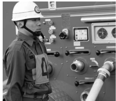
平成22年入団。 4番員は、ポンプ車を操作し水を送る。周囲の状況を見渡し、一瞬の判断で水圧を細かく調整。スロットルの開き具合が重要。
