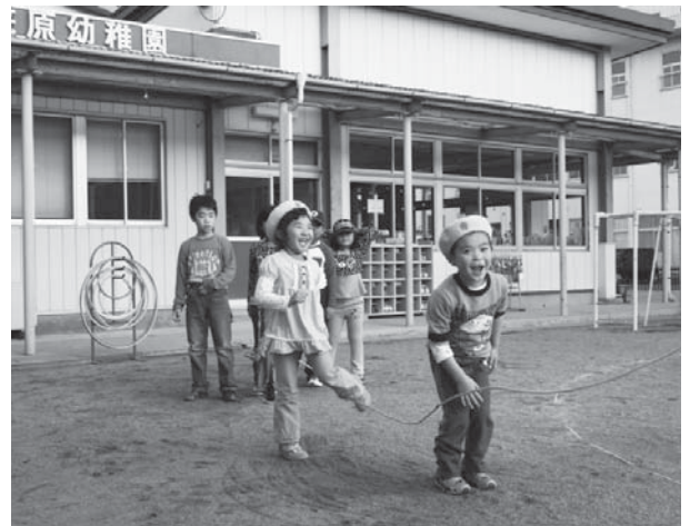
耐震補強工事が行われる笹原幼稚園
