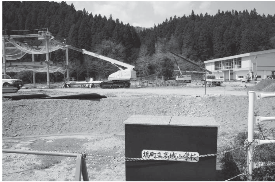
建設中の(株)オーゼキ
