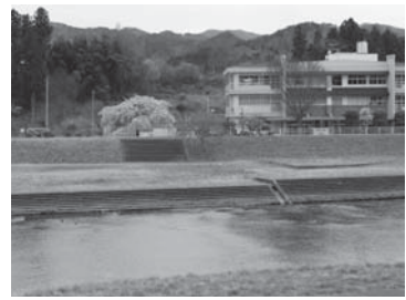
久慈川河川敷のヘリポート整備予定地
