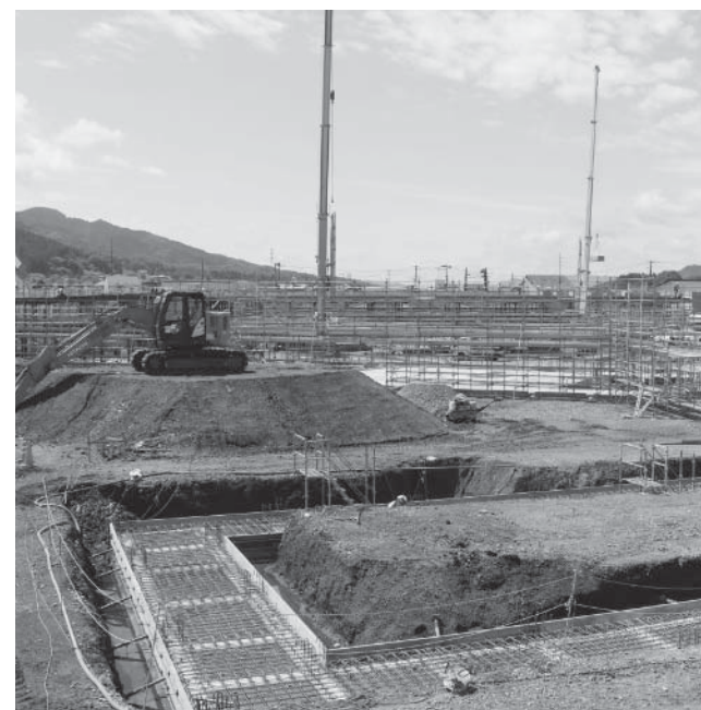
現在建設中のはなわこども園
