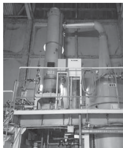
施設内のタンク
