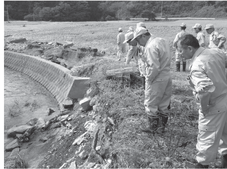
那倉地区の河川被災地を視察
