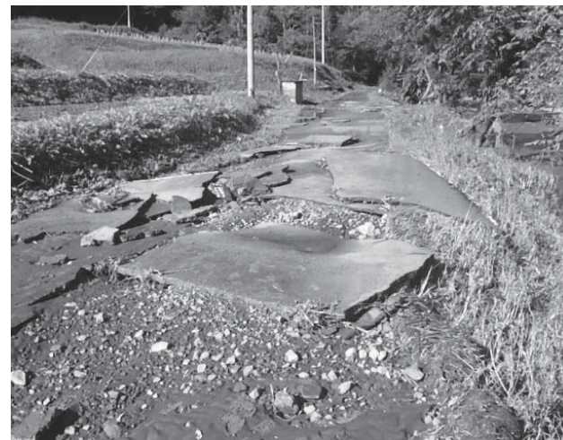
被災した町道清水和久見明線
