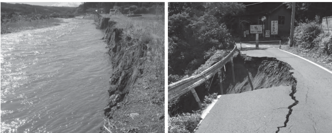
町内被災箇所（左：川上川板庭付近、右：県道高萩塙線木野反分館前）
