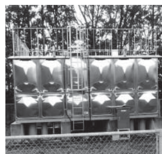
湯岐水道施設タンク
