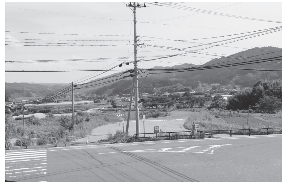
改良工事が進む町道川上東河内線（八幡側から撮影）
