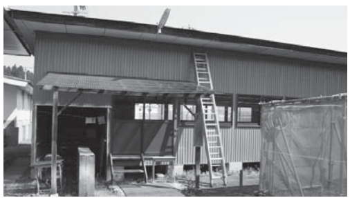
老朽化した柔道場
