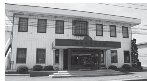
改修工事が行われる福祉会館
