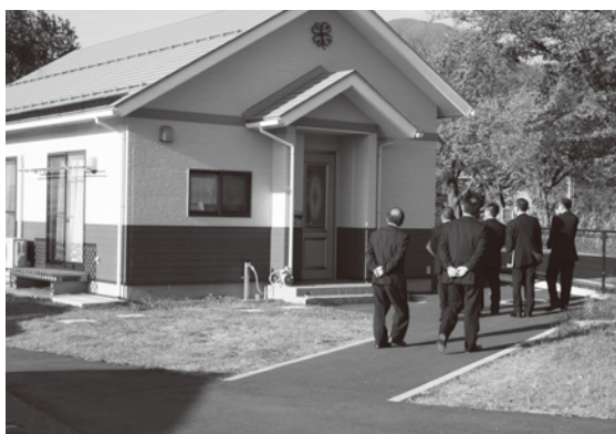
磐梯町の若者向け住宅
