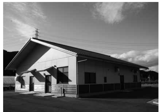
川上集落排水処理施設
