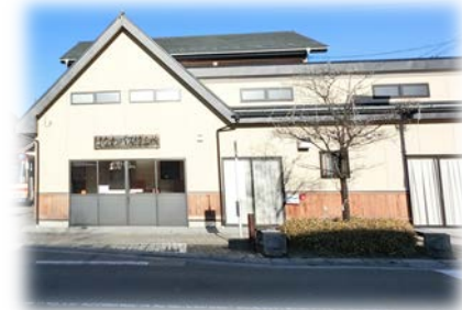
▲ 塙駅前待合室の現況
