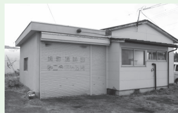
第2分団第5班(常世中野区) 消防屯所解体・新築工事費
